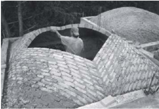
Figura 17. Construcción una cúpula recargada. México. (Fuente: A. RAMÍREZ PONCE, R. RAMÍREZ MELÉNDEZ. Curves of Clay: Bóvedas del Bajío . p.5).
