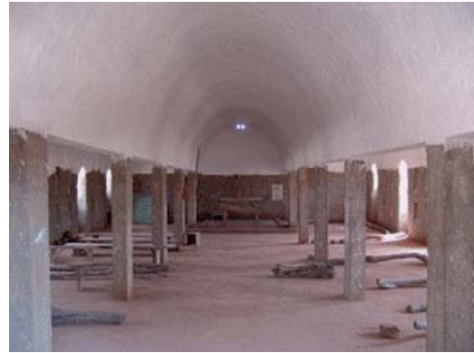
Figura 13. Iglesia en Petit-Bale, Burkina Faso. Vigas y pilares de hormigón. (Fuente: T. GRANIER, A. KAYE, J. RAVIER AND D. SILLOU. The Nubian Vault: Earth roofs in the Sahel . p7).
