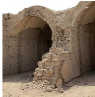
Figura 3. Bóvedas nubias de adobe en la zona de almacenes del Ramesseum, Luxor, Egipto. Datadas en el siglo XIII a. C. Se construyen varias capas o roscas. (Foto: C. Jiménez Pose)
