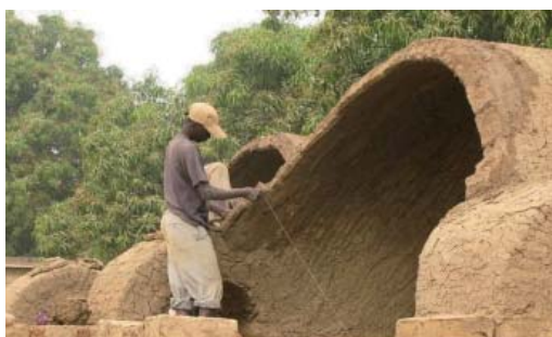
Figura 11. Constructor africano ayudándose del cable de trazado. (Fuente: T. GRANIER, A. KAYE, J. RAVIER AND D. SILLOU. The Nubian Vault: Earth roofs in the Sahel. P9 ).
