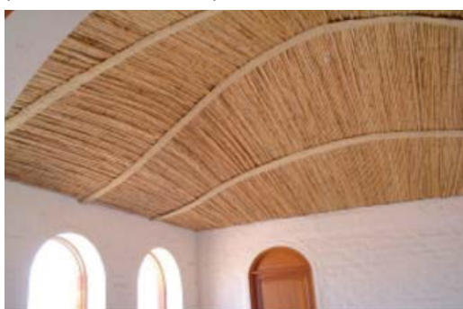
Figura 9. Techo de Domocaña en Vivienda de Huymay. (Fuente: R. Barrionuevo).
