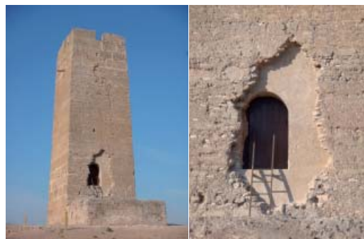
Figura 16. Restauración de la torre de Bofilla de Bétera. Valencia, España. (Fuente: Mileto & Vegas).
