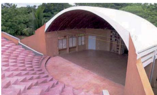
Figura 14. Sala polivalente de la Escuela Deepanam, Auroville, India. (Fuente: Auroville Earth Institute).
