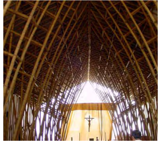
Figura 6. Ejemplos de la utilización de la caña guadua y la paja toquilla. Casa cultural elaborado en el sito de agua blanca a Puerto López, Estructura de cubierta en la iglesia de Agua Blanca.
