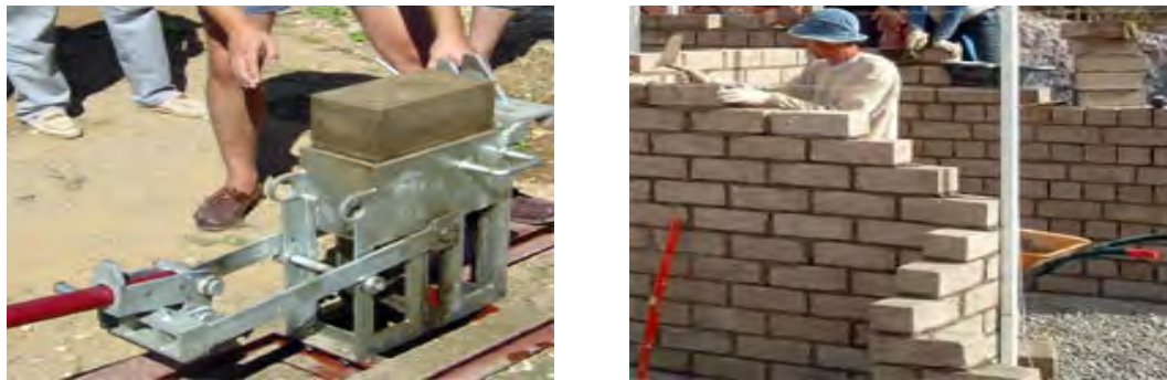
Figura 7. Ejecución del BTC y puesta en obra en Obra
