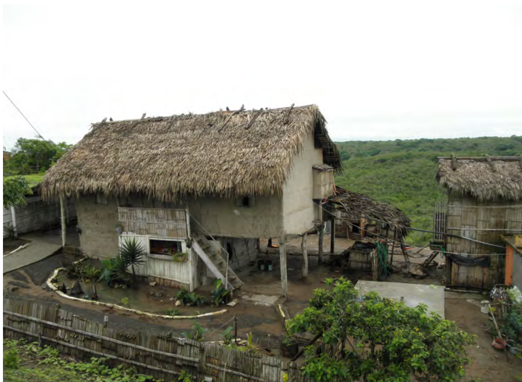
Figura 1. Vivienda Tradicional Manabita. Adaptación al clima y a los materiales tradicionales del lugar. Planta elevada del suelo mediante pilotes de madera. Estructura vertical de madera y horizontal de caña, cerramientos de “quincha” de caña picada y barro y cubierta vegetal (Foto: F. Jové)
