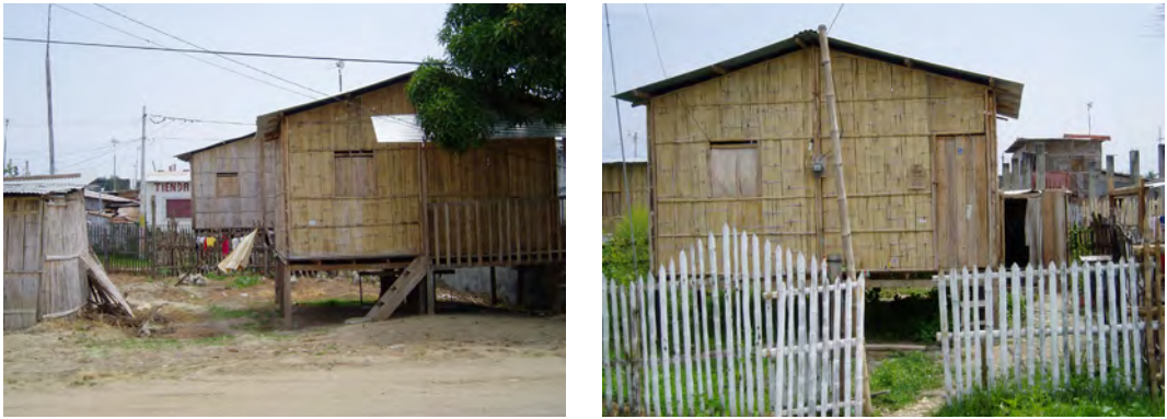
Figura 3. Viviendas de caña guadúa en las inmediaciones de Guayaquil. Modelo de casa prefabricada denominado "hogar de cristo" ensamblada mediante tableros de caña picada. Esta tipología esta promovida y desarrollada por la organización Hogar de Cristo (Foto: F. Jové)
