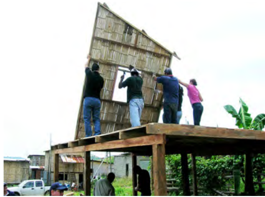
Figura 2. Plantación de Caña Guadua Angustifolia y colocación de paneles prefabricados de “caña picada” usados como cerramiento de los edificios
