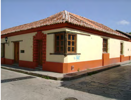
Figura 4. Vivienda tradicional con modificaciones en el marco de acceso. Fuente: Luis Guerrero.
