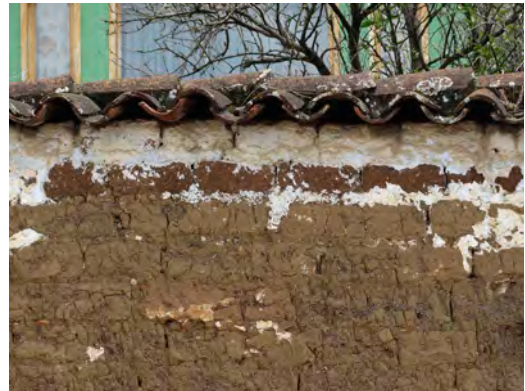
Figura 3. Restos de la pintura de cal que protege a los adobes en las fachadas. Fuente: Jaqueline Jiménez.
