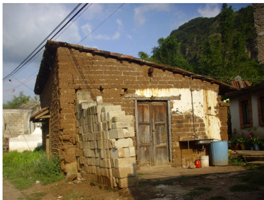
Figura 1. Casa de adobe tradicional en proceso de demolición, en Chalmita. Foto: L. Meraz.
