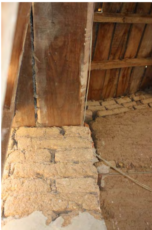
Figuras 5 y 6. Fotografía del muro separador de las dos viviendas y sección en la que se aprecia su posición sobre el muro piñón y en la jamba de la puerta principal. Fuente: F. Javier Carbayo.
