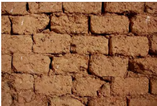
Figura 7. Imagen de un muro de adobe en obra colocado a tizón en el pajar.
