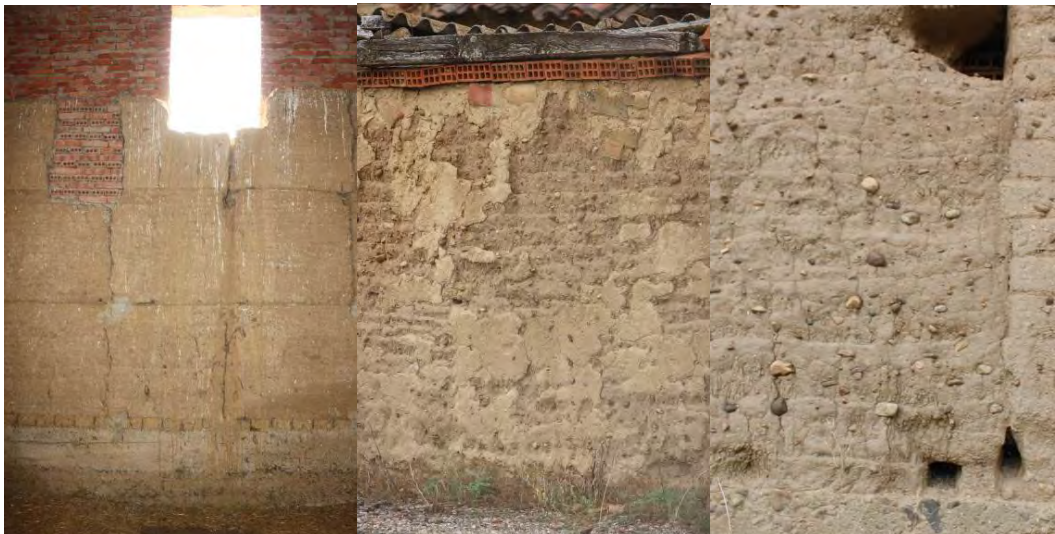
Figura 8. Muros de tapial, de izquierda a derecha; en la cuadra, en la cerca y en el acceso al pajar desde el patio.
