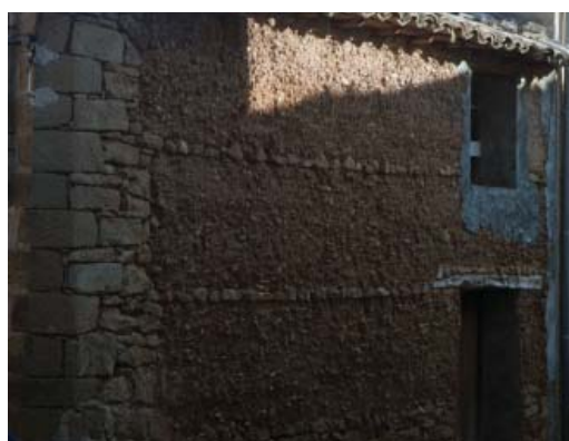
Figura 2. Tapia de Agüero sin revoco
