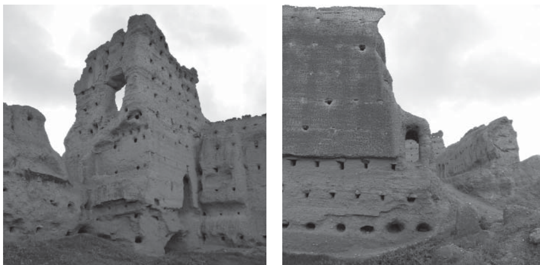
Figura 5. Vista interior de la torre suroccidental del castillo de Serón de Nágima y detalle del lienzo septentrional con fábrica de tapia de tierra en el que se abre una tronera (fotografías de Ignacio Javier Gil Crespo).
