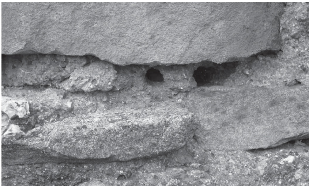
Figura 2. Detalle de los mechinales dobles de la fábrica del muro del castillo de Peroniel del Campo (fotografía de Ignacio Javier Gil Crespo).
