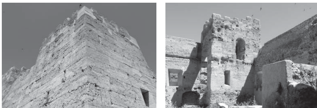
Figura 6. Torreón suroccidental del castillo de Yanguas y vista del interior del castillo (fotografías de Ignacio Javier Gil Crespo).
