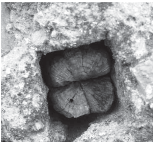
Figura 4. Media aguja de sección cuadrangular abandonada en el interior de la fábrica (fotografías de Ignacio Javier Gil Crespo).
