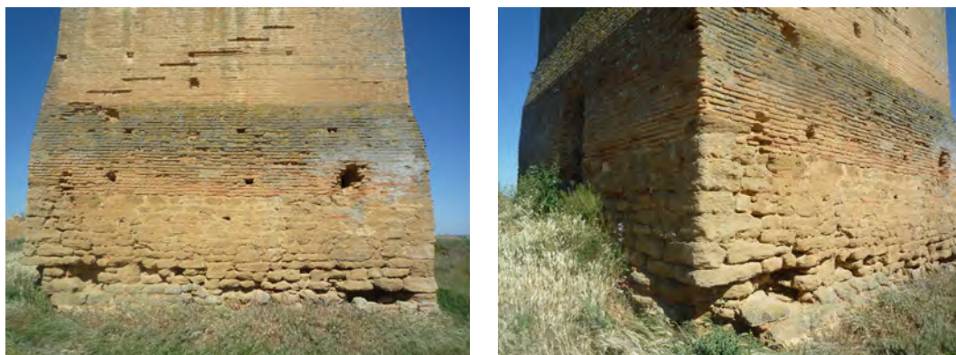
Figura 6. Detalle de la torre de la iglesia de Villacreces.
