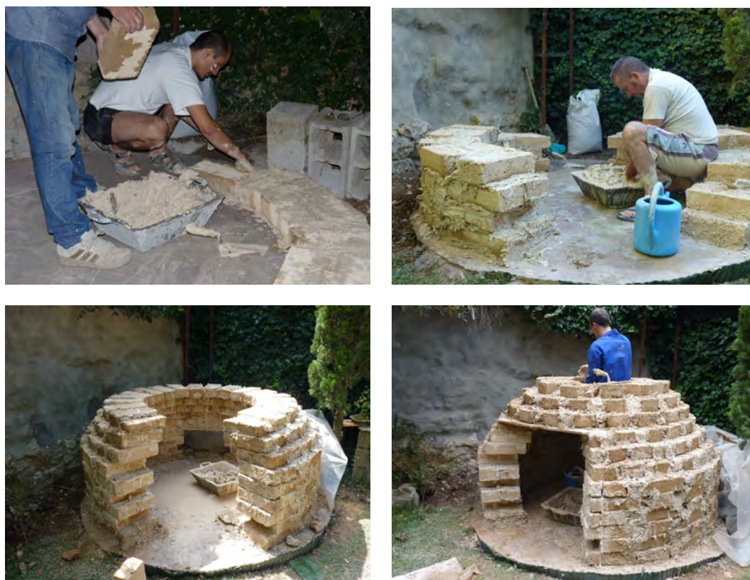
Figura 3. Secuencia del proceso de construcción del temazcal. Fuente: Boris Aparicio y Alfonso Aparicio.
