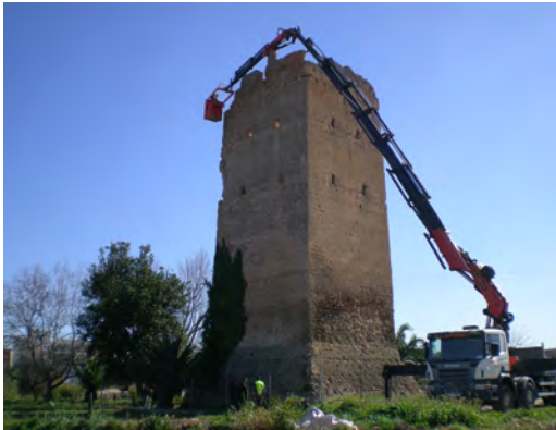
Figura 8. Inspección de la torre realizada con la grúa autopropulsada. Fuente: Vicente López-Mateu
