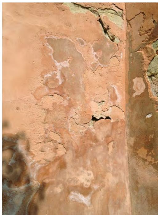
Figuras 6 y 7. Desprendimiento de revoco realizado con cemento blanco sobre fábrica de tapia. Casa-Castillo de Bétera. Fuente: autores.
