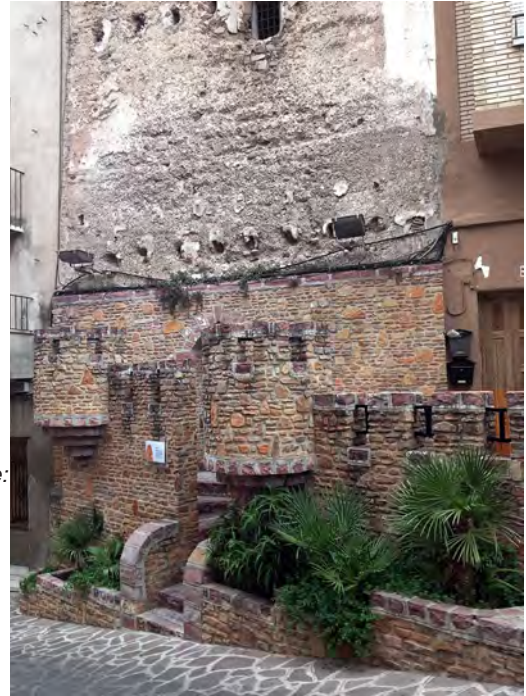
Figuras 3 y 4. Falsos históricos inaceptables en la base de una torre islámica de tapia. Vista general y detalle. Torre del Señor de la Vila. Serra. Fuente: autores.
