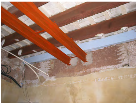
Figura 8. Refuerzo de forjado con vigas metálicas empotradas en un muro de tapia histórico. Castillo de la Señoría. Alfara del Patriarca. Fuente: autores.
