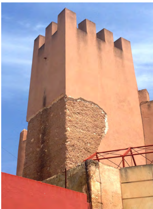
Figuras 6 y 7. Desprendimiento de revoco realizado con cemento blanco sobre fábrica de tapia. Casa-Castillo de Bétera. Fuente: autores.
