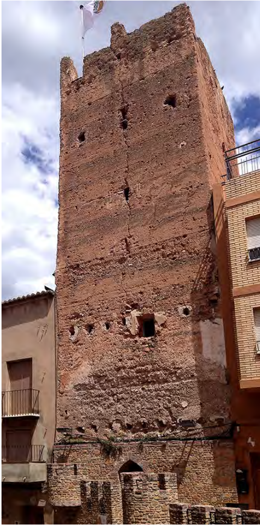
Figuras 3 y 4. Falsos históricos inaceptables en la base de una torre islámica de tapia. Vista general y detalle. Torre del Señor de la Vila. Serra. Fuente: autores.
