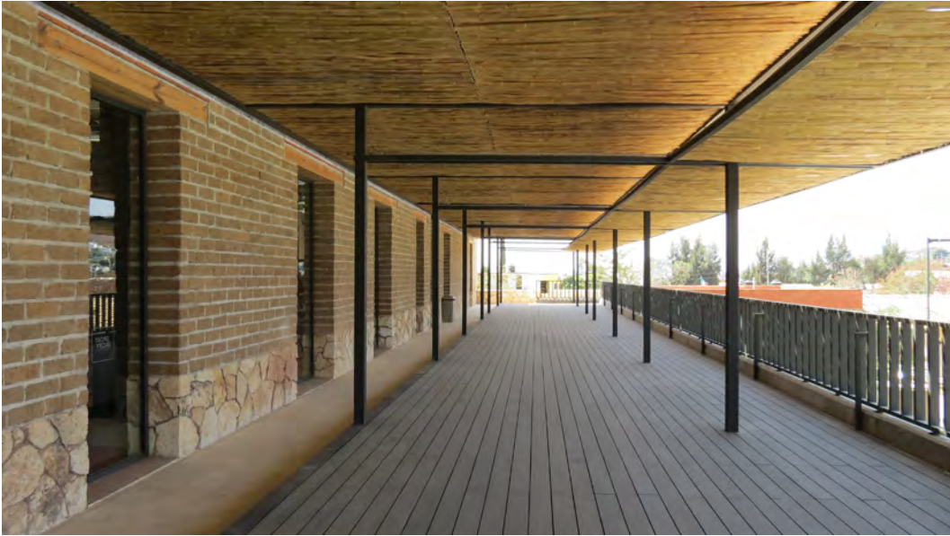
Figura 4. Vista de la terraza del complejo deportivo ya terminada. Adobe, madera, piedra, ladrillo, metal y carrizo conviven armónicamente. Oaxaca. Fuente: João Boto Caeiro.
