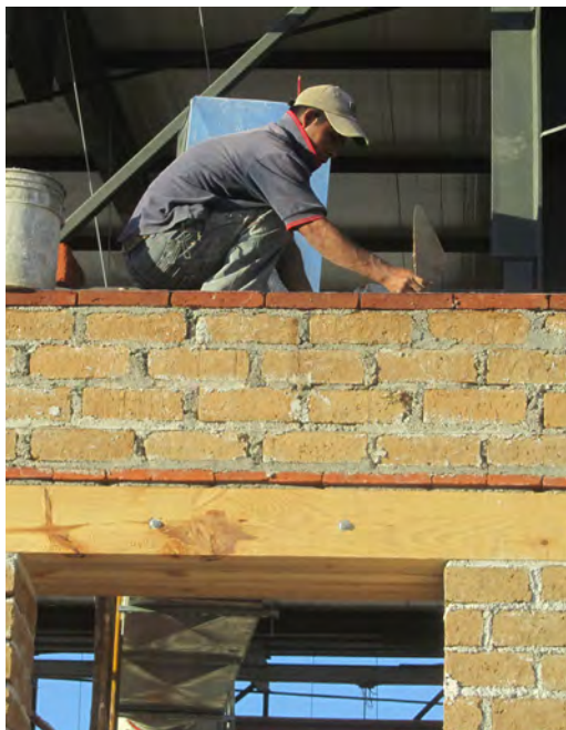
Figura 2. Proceso de construcción de un moderno conjunto deportivo diseñado bajo criterios estructurales tradicionales, y edificado a partir del manejo de materiales elaborados artesanalmente, Oaxaca. Fuente: João Boto Caeiro.
