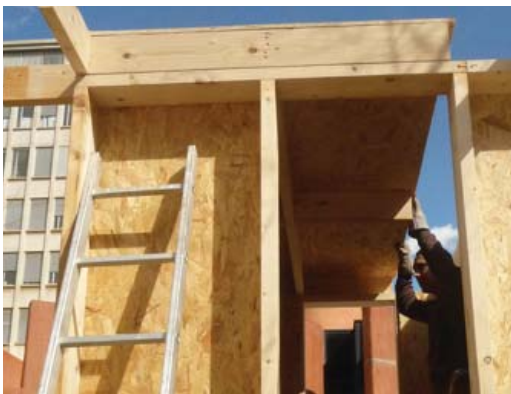
Figura 2. Vista del montaje del prototipo S-low en la UPC. Ensamblaje de muros portantes de madera y encofrado perdido. Casa S-low
