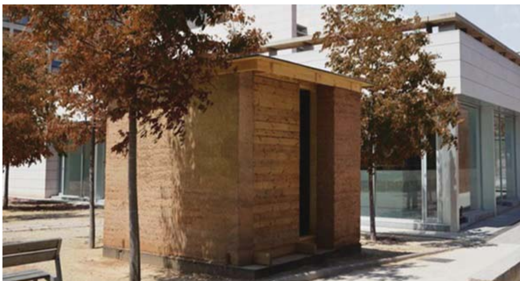
Figura 3. Prototipo ya construido e instrumentalizado para el estudio de su comportamiento termohigrométrico. Fuente: Allepuz, Poza.
