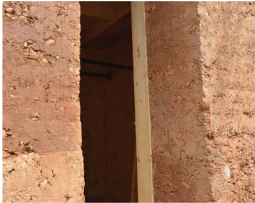
Figura 4. Detalle de los elementos de cerramiento y sus texturas. Fuente: Allepuz, Poza
