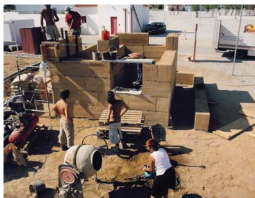
Figura 4. Execução da escultura em taipa de Pedro Fazenda “para percorrer”. III Simpósio de Escultura em Terra(cota). Parque de feiras de Montemor-o-Novo. Fonte: Tiago Fróis. 2001.
