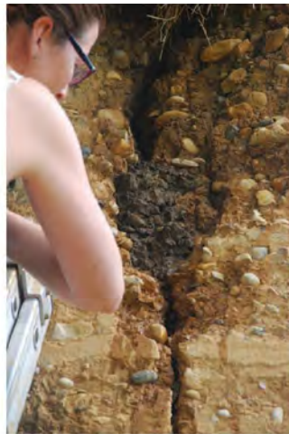
Remplissage avec mélange humide comprenant beaucoup de galets
