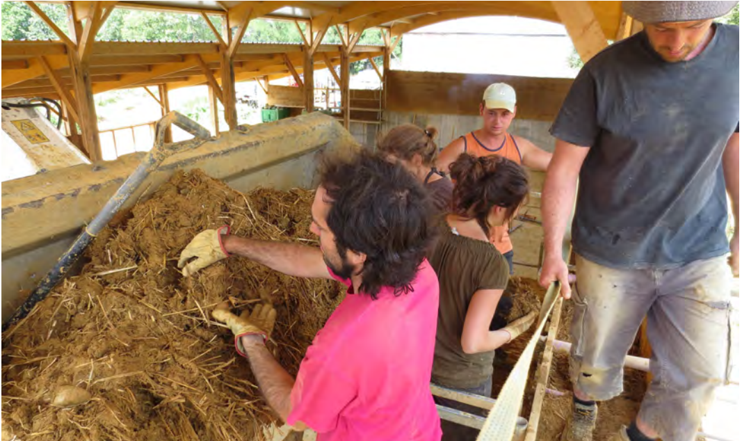
Figura 6. Prácticas profesionales de cuatro estudiantes de la promoción 2012-2014. Construcción de bodega de cob encofrado en Normandía, Francia. Fuente: Elena Camarasaltas Pérez 2013.
