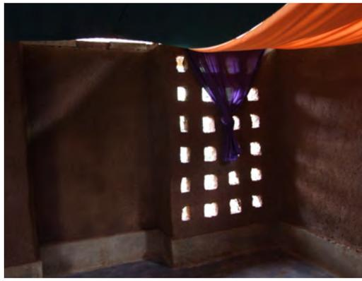
Figura 8 (arriba). Proceso de fabricación de los adobes y colocación de los mismos en obra. Figura 9 (abajo). Celosía como alternativa a la ausencia de ventanas.
