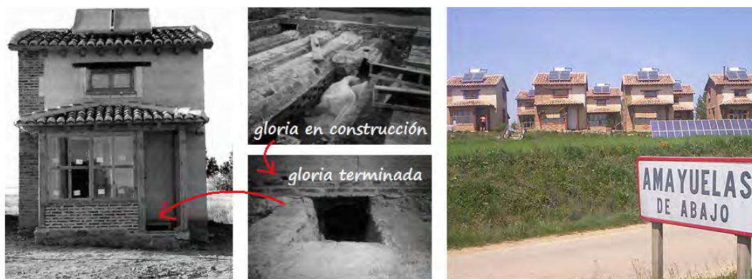
Figura 4. Viviendas bioclimáticas de tierra en Amayuelas de Abajo, Palencia, 2000.
