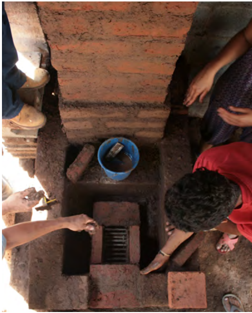
Figura 5. Izda: Construcción de la cámara de combustión de la cocina modelo. Fuente: Monika Marchewka. Enero 2013. Dcha: Construcción de la chimenea de la cocina modelo. Fuente: Leticia López. Enero 2013.
