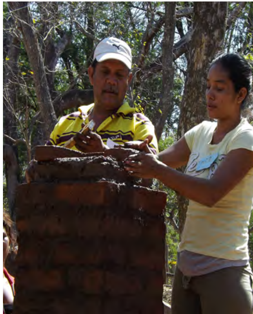
Figura 5. Izda: Construcción de la cámara de combustión de la cocina modelo. Fuente: Monika Marchewka. Enero 2013. Dcha: Construcción de la chimenea de la cocina modelo. Fuente: Leticia López. Enero 2013.
