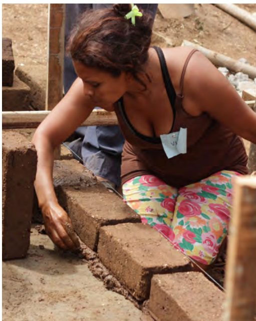
Figura 3. Izda: Materiales necesarios para la construcción de un fogón mejorado de adobe. Acervo personal. Enero 2013. Dcha: Mujer construyendo el fogón modelo. Fuente: Panxa Fábregas. Enero 2013.
