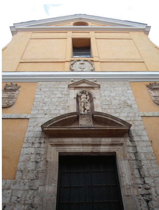
Figura 4.- Portada de la Iglesia del convento de San Ignacio. Se observa la combinación de machones y verdugadas de piedra de sillería con cajones de tapia. Fuente: F. Jové.
