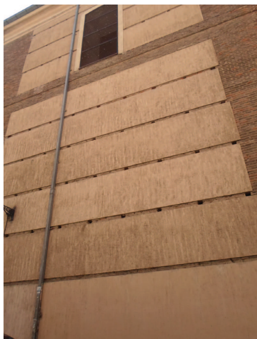
Figura 7.- Tapia encadenada en la variante de machones rectos y verdugadas de ladrillo, en la cercana Iglesia del convento de San Quirce. Fuente: F. Jové.
