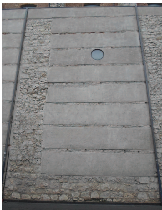
Figura 6.- Tapia encadenada de la Iglesia del cercano Convento de San Agustín. En ella se observa con claridad el sistema constructivo. Fuente: F. Jové.
