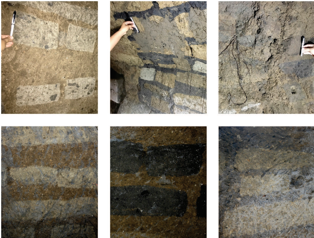
Figura 4. Ejemplos de adobes de diferente color y textura, colocados a manera de tareas localizadas en el Edificio 3 de Cholula. Fuente: Marcela Galván y Fernando Uriostegui.
