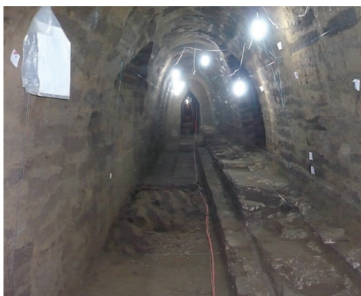
Figura 3. Sector de la Gran Pirámide donde se observa la colocación de los adobes en forma de tarreas. Fuente: Carlos Cedillo.
