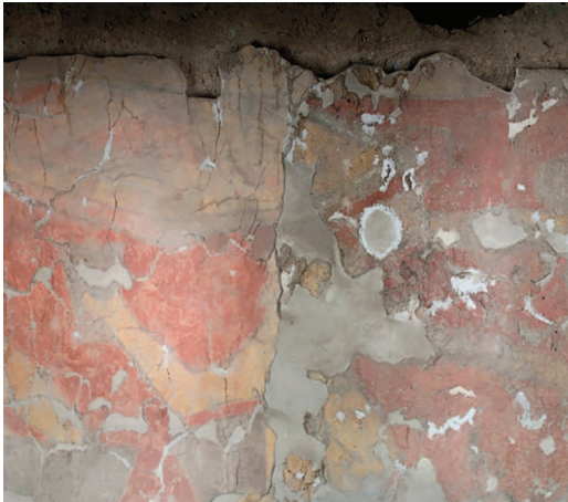
Figura 2. La observación del Mural de Los Bebedores permite reconocer el uso de un aplanado de tierra, que sirve como preparación para recibir a la capa pictórica (sector izquierdo). Sin embargo, en ocasiones dicho aplanado no está presente (sector derecho), lo cual favorece considerablemente la pérdida de esta capa de color. Fuente: Alfonso Osorio.
