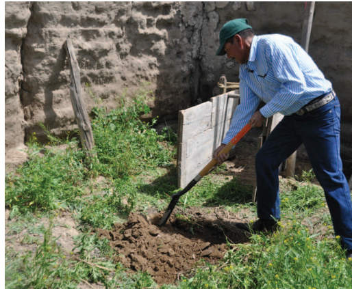
Figura 4. Encofrado tradicional para tapia de tierra en San Andrés Payuca, Puebla. Fuente: Acervo del LABPySC FA/UNAM.
