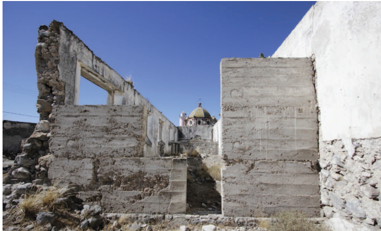
Figura 2. Vestigios de tapias de piedra poma en Tepeyahualco, Puebla. Fuente: Acervo del LABPySC FA/ UNAM.
