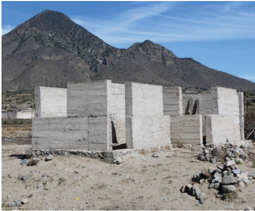
Figura 5. Tapias de piedra poma y residuos de cal en Tepeyahualco, Puebla. Fuente: Acervo del LABPySC FA/UNAM.
