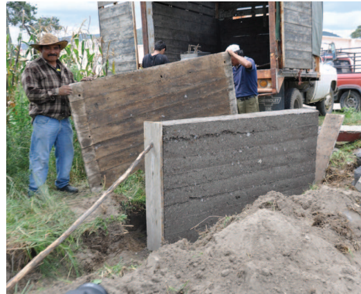
Figura 6. Procedimiento constructivo: descimbrado de tapia de piedra poma, Tepeyahualco, Puebla. Fuente: Acervo del LABPySC FA/UNAM.
