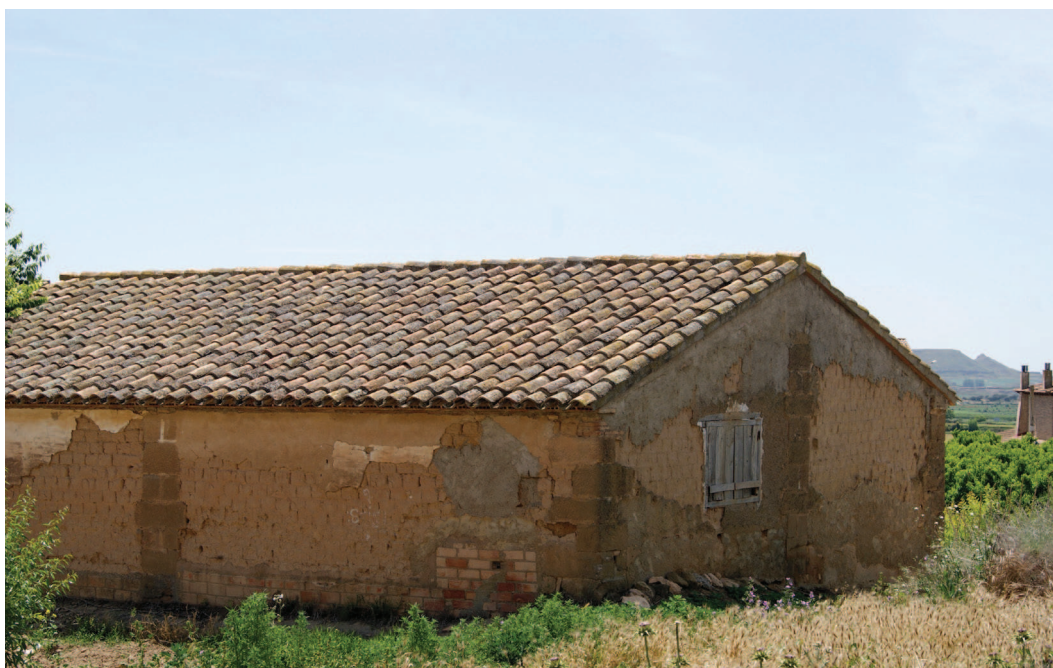
Figura 4. Construcción de adobe con machones de sillería. Valcarca (Huesca), 22 mayo 2017. Fuente: L. Villacampa.
