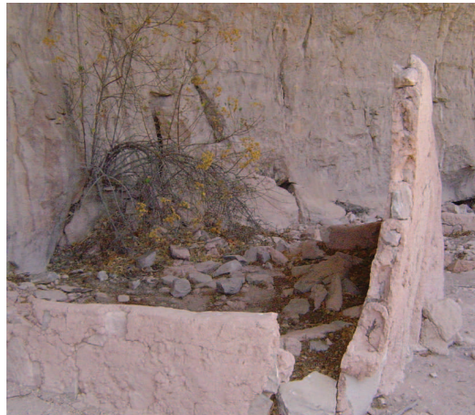
Figura 8. Detalle sistema constructivo de mampostería de tierra y piedra E1 CMAG2. Fuente: J. L. Punzo Díaz.
