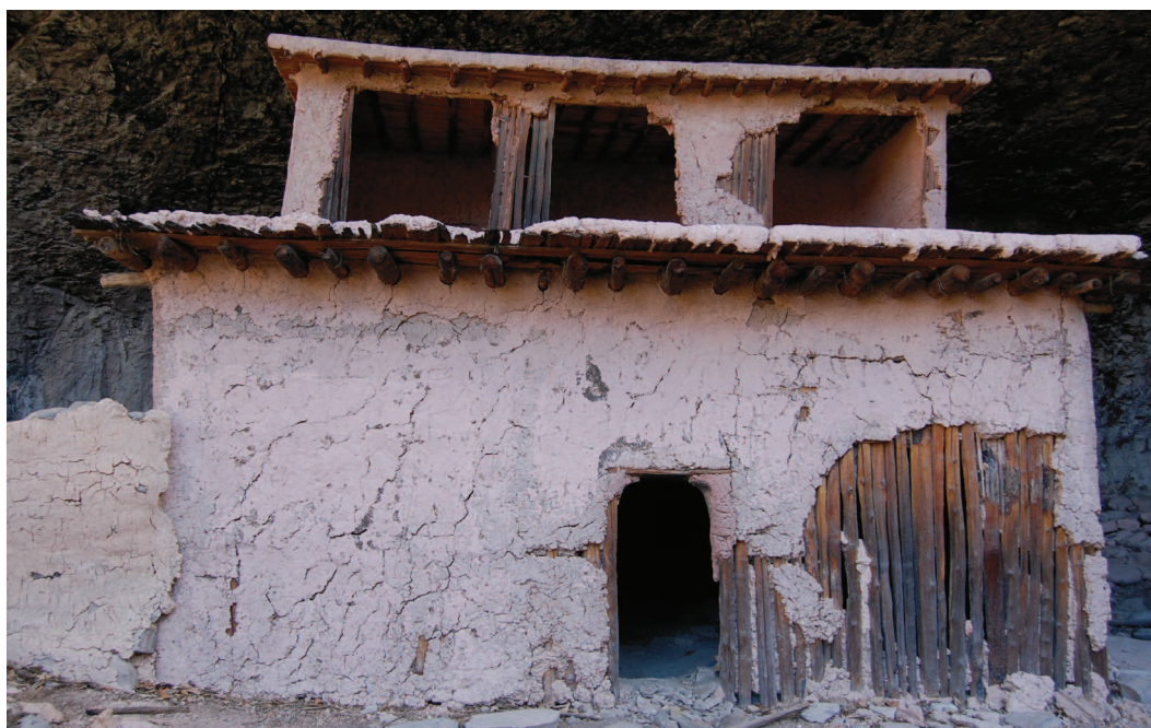
Figura 5. Detalle de muro de bajareque E2 muro sur CMAG1. Fuente: J. L. Punzo Díaz.
