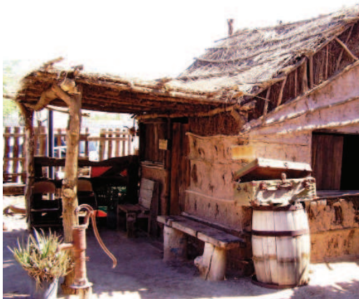
Figura 7. Vivienda vernácula mexicalense, que constaba de una habitación, pórtico frontal y cubierta a dos aguas. Colonia Granjas Virreyes. Colección C. Robles. Ca. 2009.
