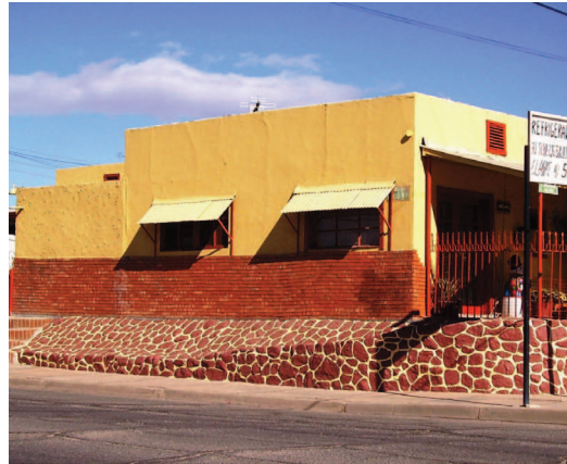
Figura 12. Vivienda de adobe en Pueblo Nuevo con pretil y ático de madera ventilado. Colección C. Robles. Ca. 2009.
