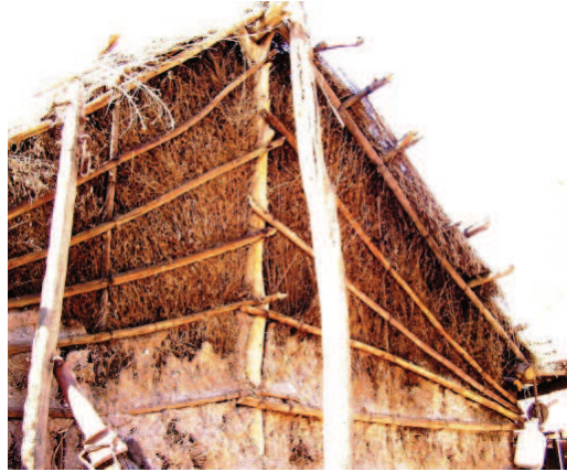
Figura 8. Vivienda vernácula mexicalense. Detalle de armado en muro. Colonia Granjas Virreyes, Colección C. Robles. Ca. 2009.
