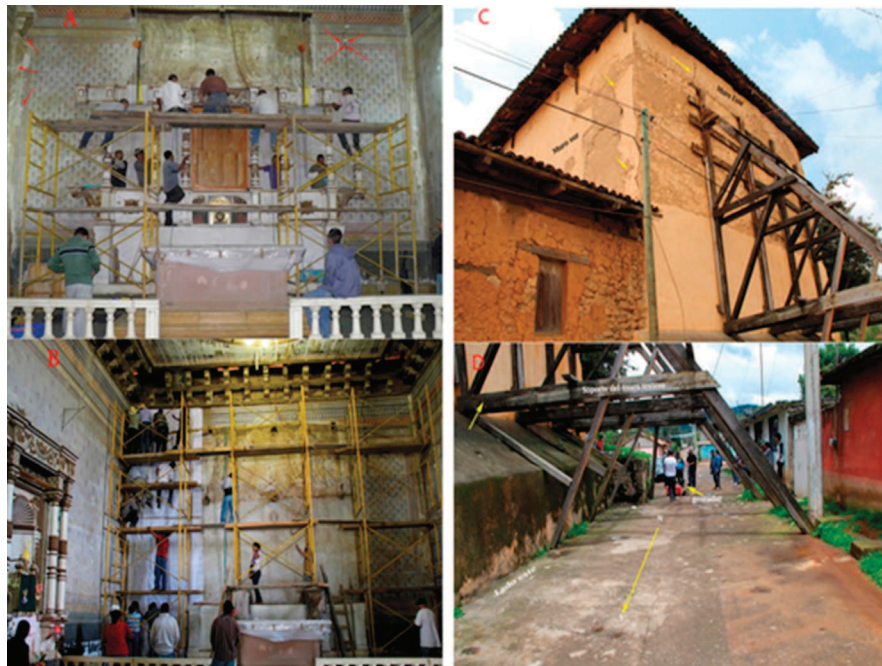
Figura 3. (A) Desmontaje del retablo principal y (B) cuadrícula de sondeos con georadar. (C) y (D) parte posterior del muro testero. Obsérvese en (D) sondeo con georadar con antena de baja frecuencia (200MHz) para detectar probables fracturas y fallas geológicas en el subsuelo. Fuente: J. Ortega.
