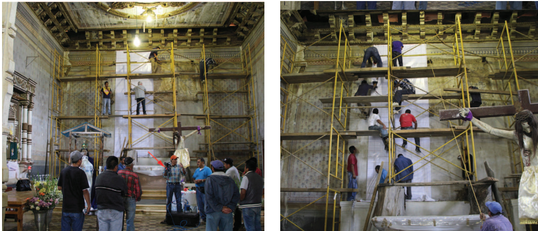
Figura 4. (A) La flecha señala la antena de 1500 MHz con su vehículo con odómetro integrado para su transporte y en (B) sondeos sobre el muro testero con líneas de sondeo a cada 5 cm. Fuente: J. Ortega.
