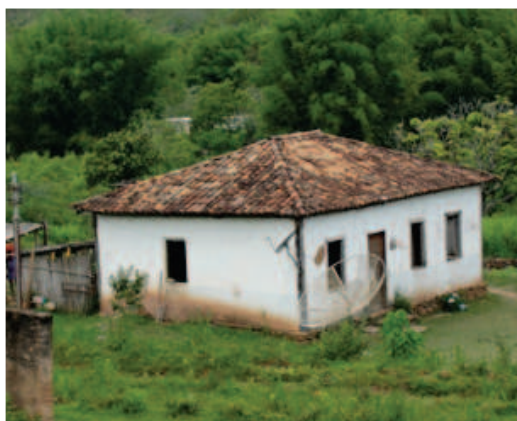
Figura 3. Foto construção em adobe revestida, Bichinho, Brasil. Fonte: J. Leite, 2012.
