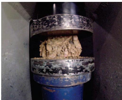
Figura 3. Prueba de resistencia en Muestra 1. Fuente: Archivo propio..
