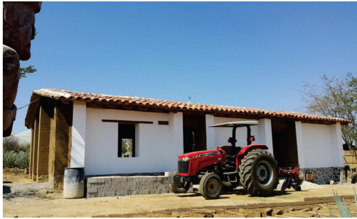
Figura 1. Fábrica de mezcal “La Candelaria”, ubicada en Santa Catarina Minas, Oaxaca. Nave de 90 m 2 realizada con adobes y cocina realizada con bahareque, ambos con subproductos del mezcal. Fuente: Archivo propio.
