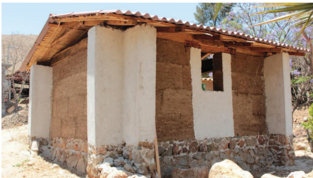
Figura 3. Prototipo finalizado. En la fotografía es posible ver las marcas del proceso de construcción. Fuente: A. Montes González.
