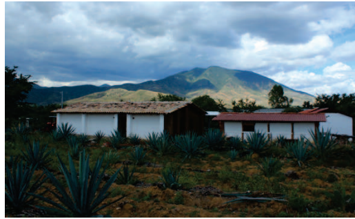
Figura 1. Fábrica de mezcal “La Candelaria”, ubicada en Santa Catarina Minas, Oaxaca. Nave de 90 m 2 realizada con adobes y cocina realizada con bahareque, ambos con subproductos del mezcal. Fuente: Archivo propio.
