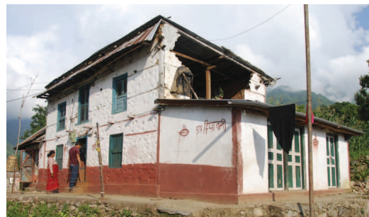
Figura 5. a) Esquema de la estructura interior de madera y del efecto ariete, Technical guide for master trainers CRATERRA. b) Ejemplo de la situación en la que el empuje de la viga central ha colapsado el testero. Julio de 2015. Fotografías: Equipo Awasuka.
