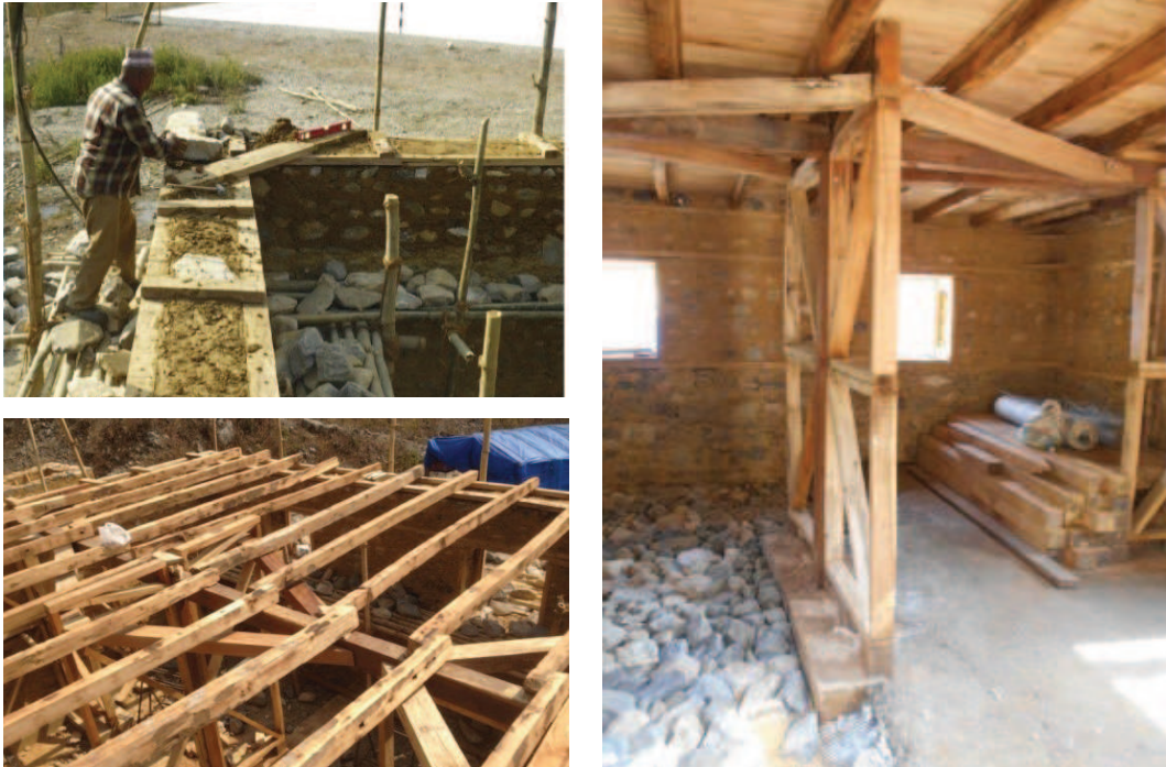
Figura 8. a) Bandas horizontales, b) Diagonales de los forjados y viguetas pasantes, c) Módulos de rigidización de los pilares. 2017. Fotografía: Equipo Awasuka.
