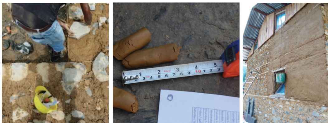
Figura 9. a) Mampostería de piedra careada y mortero de barro. b) Tests para determinar proporciones adecuadas para el mortero. c) Revoco de arcilla con excrementos de vaca y búfala. 2016 - 2017. Fotografía: Equipo Awasuka.
