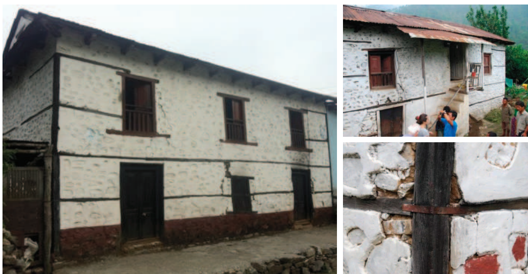
Figura 3. Ejemplo de vivienda tradicional rural con detalles sismorresistentes, algunos de los cuales han sido ejecutados de forma deficiente. Julio de 2015. Fotografía: Equipo Awasuka.
