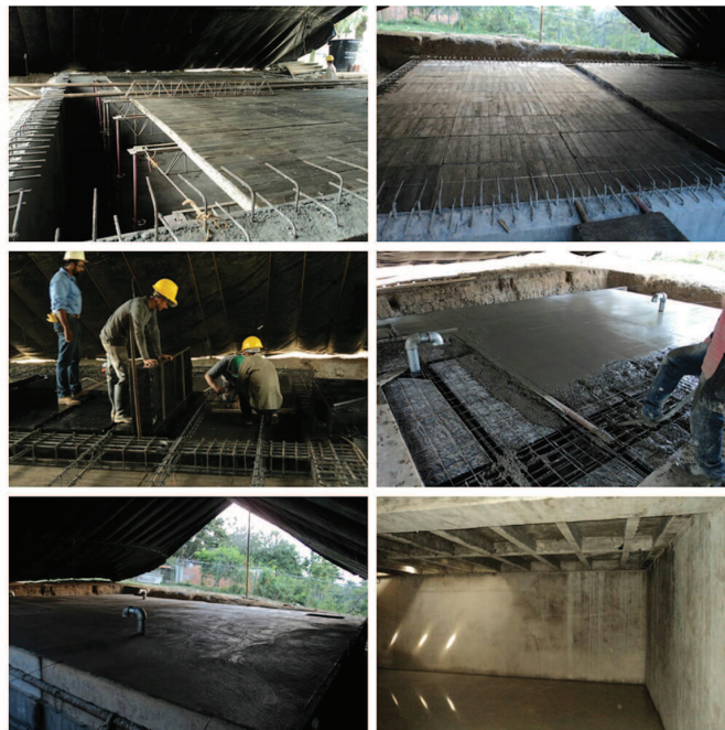
Figura 4. Proceso de aligeramiento de losas mediante el uso de casetones convencionales. Fuente: O. Hurtado y J.A. Cárdenas.
