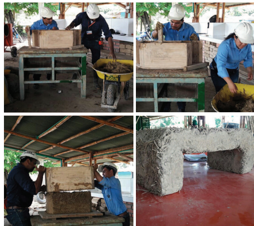
Figura 10. Confección del Casetón. Fuente: O. Hurtado y J.A. Cárdenas.
