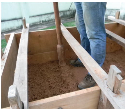
Figura 3. Compactação da miniparede. Fonte: Acervo da autora, 2016.
