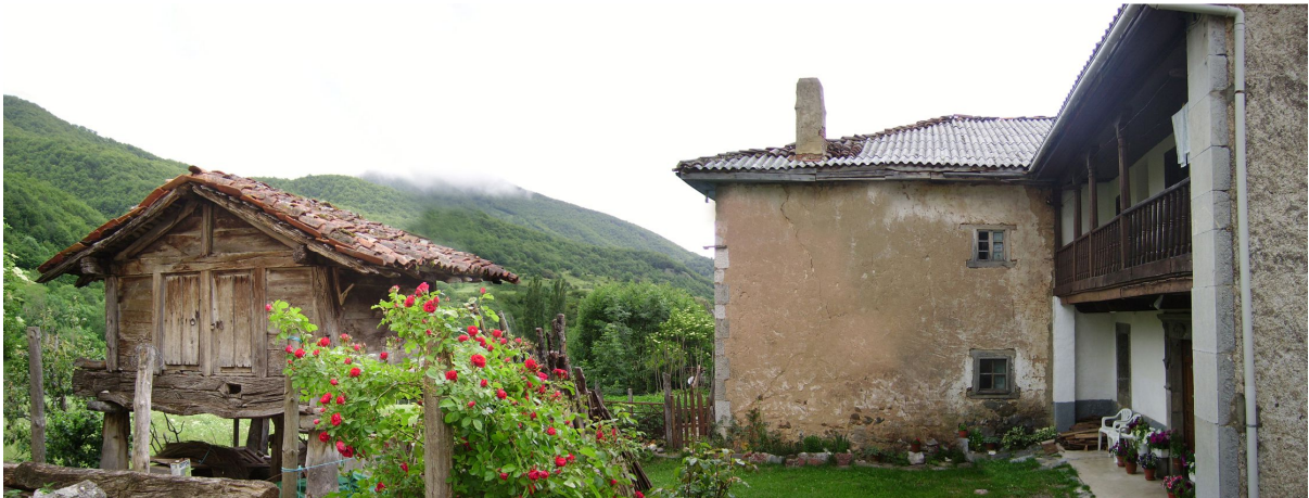
Conjunto de vivienda con corredor, corral y hórreo. Santa María de Valdeón, León
