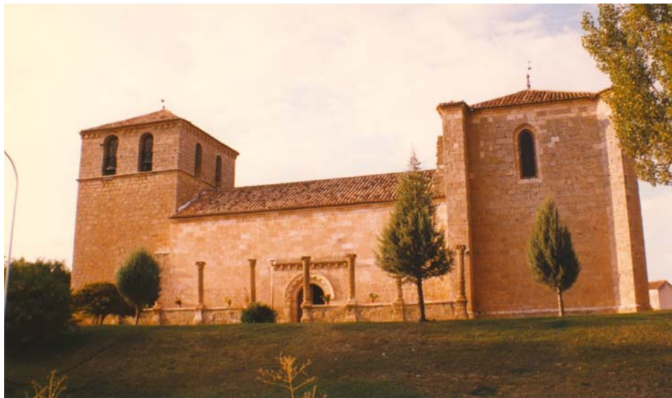
Fig. 1.- Vista general de la iglesia parroquial de San Nicolás de Bari y de su entorno próximo. (Biblioteca Municipal de Aranda de Duero. Archivo fotográfico)
