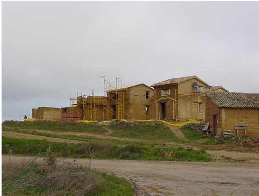
Fig. 1.-Viviendas construidas con tapia, adobes y Bloques de tierra compactada en Amayuelas de Abjo (Palencia) promovidas por la Cooperativa Entramado S.Coop.
