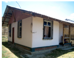
Figura 29. Prototipo Vivienda Social con guadúa empañada con mortero arena - cemento. Autores: Arq. Rafael Rojas y Arquitectura Viva, Año 2003. Santa Ana Manabí
