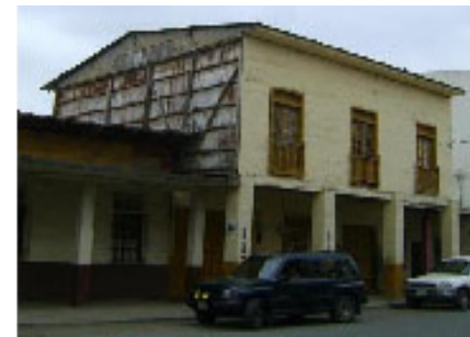
Figura 05. Casa Urbana de madera y caña enquinchada. Autores maestros de oficios (carpintería de rivera) a inicios del S. XX.
