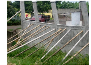
Figura 23. Apuntalada de muros pesados.
