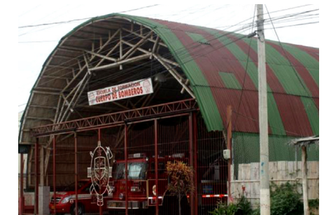
Figura 25. Galpón en caña guadúa. Cuerpo de Bomberos. Autor: Empresa Arquitectura Viva. Año 2006 - Manta.
