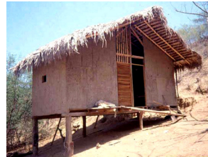
Figura 10. Casa sobre pilotes adaptada a la topografía
