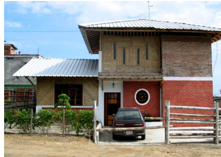
Figura 27. Casa contemporánea con Técnicas mixtas. H.A, ladrillo y caña guadúa. Autor:Arquitectura Viva Manta - 2006.
