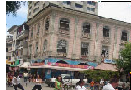
Figura 06. Edificio de madera y caña guadúa en Manta. Autores maestros de oficios (carpintería de rivera) a inicios del S. XX.
