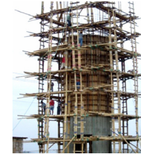
Figura 21 y 22. Encofrados y Andamios
