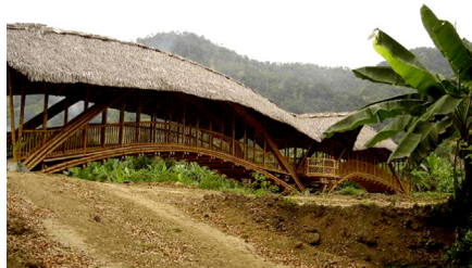
Figura 26. Puente Peatonal en Finca Eco Turística- Portoviejo. Autor : Maestros de Oficio. Inicios S XXI
