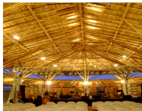
Figura 28. Auditorio Museo Amantes de Sumpa construido en guadúa. Santa Elena - 2006.
