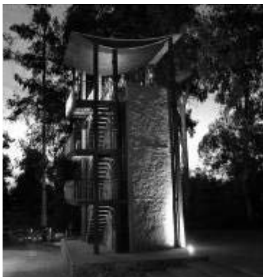
Figura 14. Torre Granja Aventura
