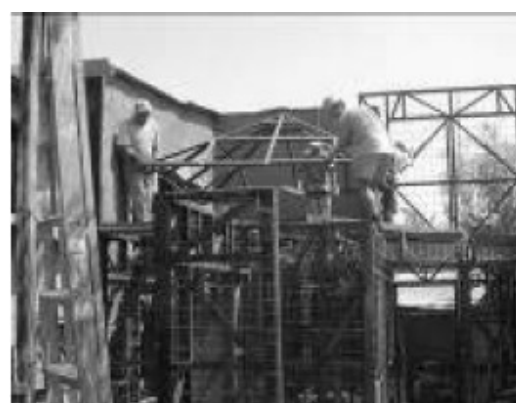
Figura 11. Prefabricación taller casa
