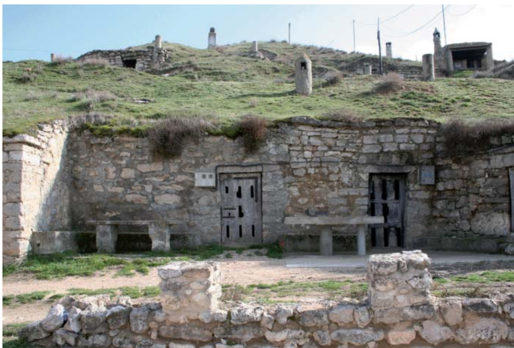
Figura 5. El barrio de bodegas de Baltanás (Palencia). Frente de fachada, puertas de acceso, chimeneas, manto vegetal y niveles superiores.
