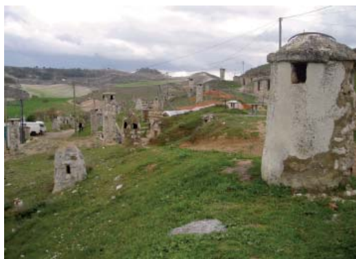
Figura 2. En primer término chimeneas de ventilación.
