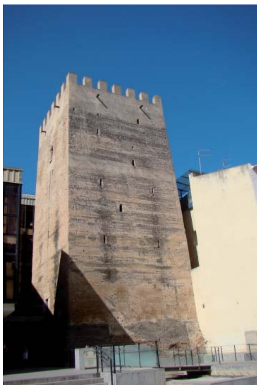
Figura 8. Torre de la Plaza.
