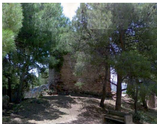
Figura 11. Torre de la Ermita.
