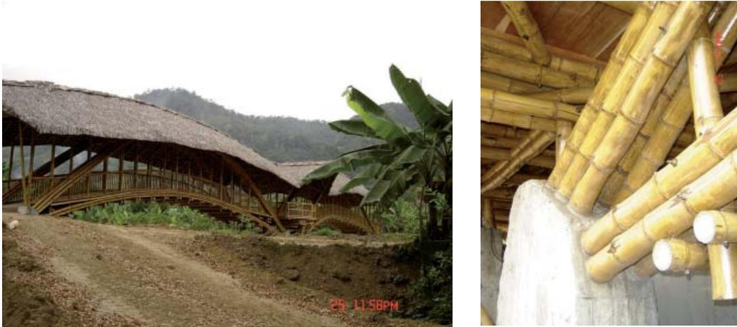
Figura 7. Puente peatonal turístico en la zona rural de Manabí. Detalle de uniones y ensamblajes. Autor: maestro Manuel Bravo y su equipo (se inició hace 20 años en Amingay). Inicios del SXXI.
