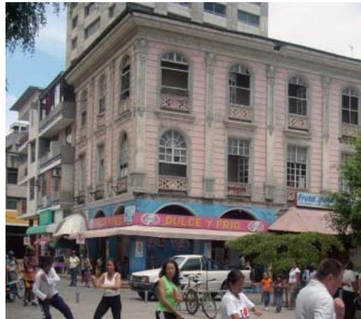
Figura 4. Edificio de madera y caña en Manta. Autores maestros de oficios (carpintería de ribera) a inicios del SXX.
