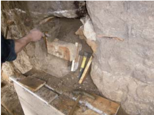
Figura 9. Relleno manual de los huecos mediante material de aportación, vertiendo la tierra y aplastándola contra el fondo del hueco con la mano o con la paleta. (Foto: los autores).
