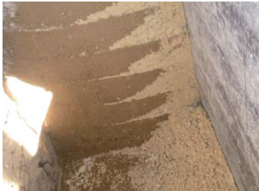
Figura 15. En la fotografía se aprecia con claridad el ángulo de rozamiento natural del mortero de cal, que posteriormente será cubierto por el vertido de la tierra. (Foto: los autores).
