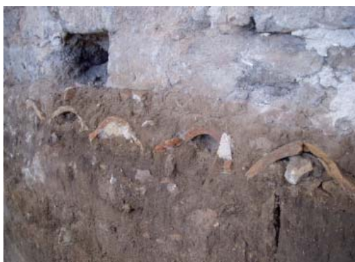
Figura 6. Tejas incrustadas en el muro que marcan un cambio de espesor del paramento. Se corresponden con la cubierta de antiguas dependencias anexas hoy demolidas. (Foto: los autores).
