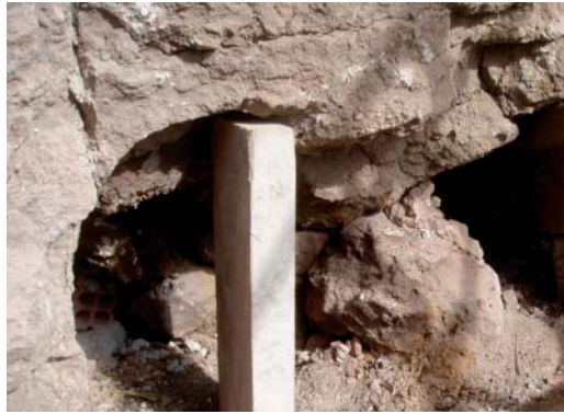
Figura 2. Apuntalamiento o cuajado provisional de los huecos mediante tacos de madera aserrada. (Foto: los autores).
