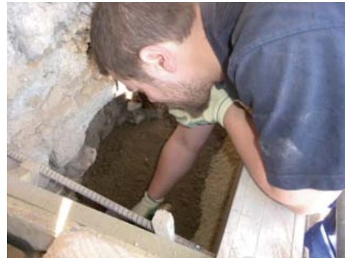
Figura 16. Vertido de tongadas de tierra de 15 cm. La mezcla debe ser correctamente distribuida para obtener un espesor homogéneo. Tras el pisado, la tongada quedará reducida a 10 cm. (Foto: los autores).
