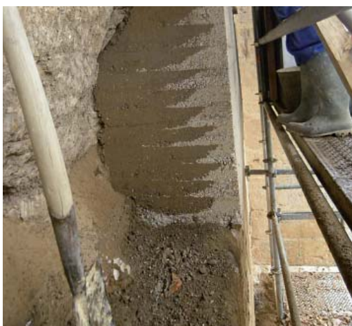
Figura 17. Imagen del costero de unos de los cajones una vez desencofrado. Se observa la sección característica del muro calicestrado. (Foto: los autores).
