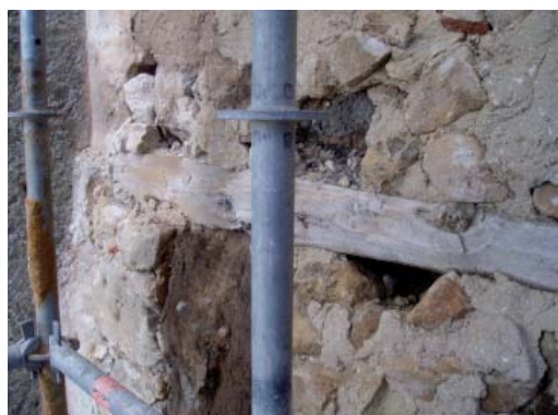
Figura 7. Grapas de madera que atan las dos fábricas: la de piedra y la de tapial. Entre ambas se ejecutó un relleno mediante mortero de tierra y cal con ripio de piedra. (Foto: los autores).
