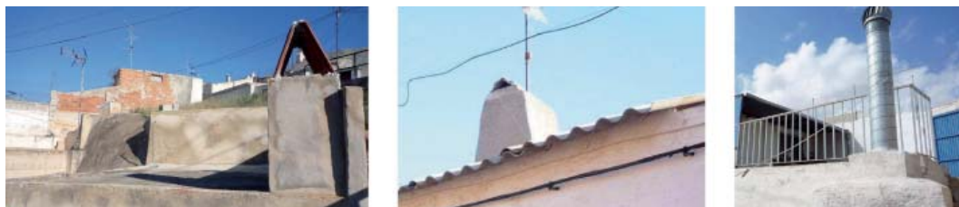
Figura 19. Chimeneas en la calle Vaiona, en la calle Sendra y en la calle Taibilla, respectivamente. En el último caso se ha incorporado un tubo metálico para aumentar el tiro y ventilar mejor el interior de la cueva. (Fotos: B. Piedecausa).
