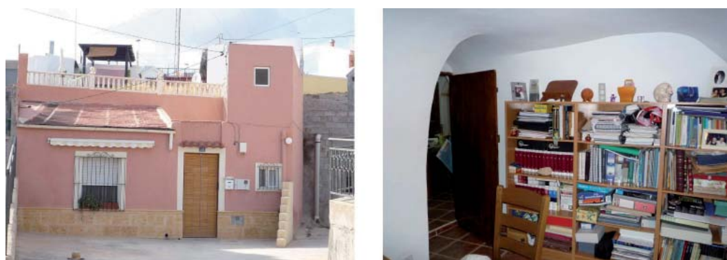
Figura 15. Tipología de Casa + Cueva. Izqda.: Fachada exterior. Apariencia de vivienda convencional no excavada. Dcha.: Imagen de la curvatura de techos de los espacios excavados. (Fotos: B. Piedecausa).
