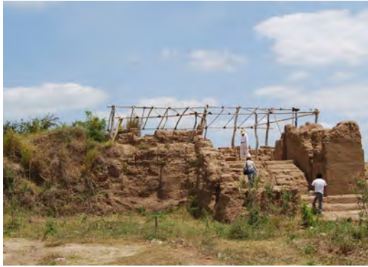
Fig. 3.- Restos de las tres últimas etapas constructivas. Fuente: Luis Guerrero 2009.
