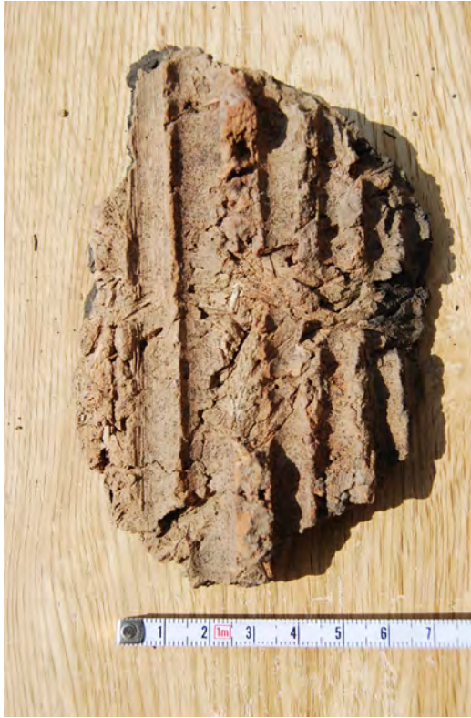
Fig. 7.- Restos calcinados de la cubierta con las improntas de los carrizos de soporte. Fuente: Luis Guerrero 2012.
