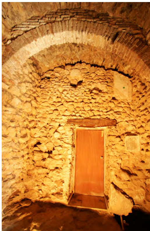
Fig. 5. Alzado noreste del interior de la torre-puerta del Cómpea, donde quedan exiguos restos de una fábrica de tierra, posteriormente reforzada y cubierta casi en su totalidad con piedra.
