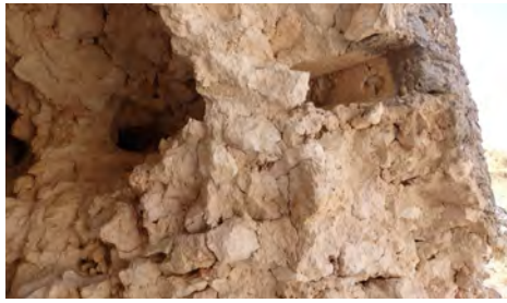
Figura 16. Sección de la muralla donde se observa un mechinaal cuya aguja se ha perdido. Autora: Alicia Sainz Esteban.
