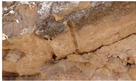
Figura 19. Impronta de las varillas pareadas en la cara inferior de un cajón. El cajón inferior ha perdido parte de material dejando al descubierto el sistema constructivo. En el canal todavía quedan restos de la varilla de madera. Autora: Alicia Sainz Esteban.
