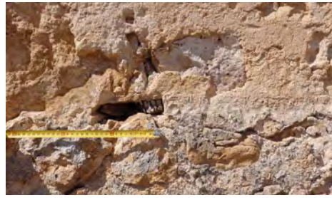
Figura 17. Aguja de madera en el muro. Autora: Alicia Sainz Esteban.
