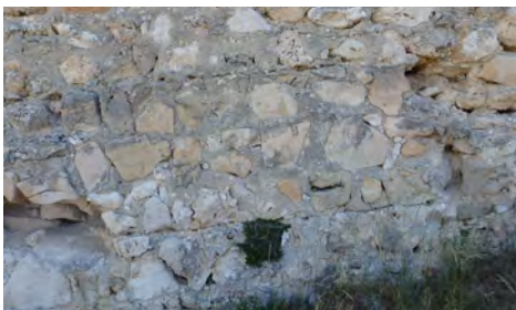
Figura 13. Lienzo con mampostería encofrada. Exterior de la muralla. Autora: Alicia Sainz Esteban.
