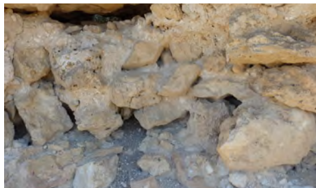
Figura 12. Interior del muro, donde se ven las piedras desordenadas, que han sido vertidas.
