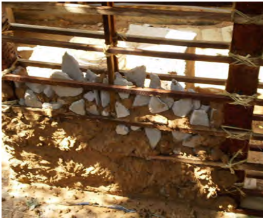
Figura 4: Enlatado doble amarrado a los horcones y relleno con escombros de bloques de cemento mezclados con barro Fuente: Andrea Mara Henneberg de León
