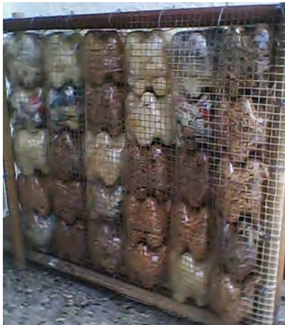
Figura 5: Propuesta de estudiante Giselle Luzardo de una pared de bahareque rellena con botellas de plásticos Fuente: Giselle Luzardo
