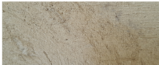
Ilustración 3 Acabado final de pañete muestra 2. Fuente: Elaboración propia. (López, 2017)
