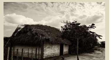
Fig. 3 Vivienda de bahareque situada en el barrio mata de bijao municipio de Pelaya (elaboración propia)
