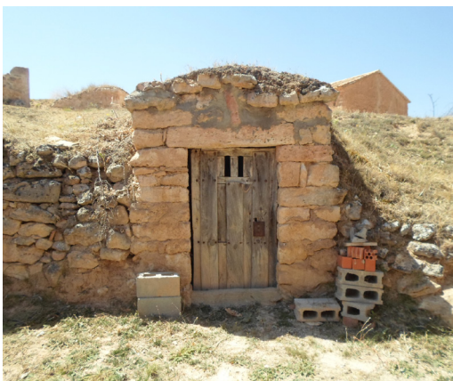
Figura 4. Puerta de acceso a bodega; tipo huecos superiores. (Fuente: F. Jové).
