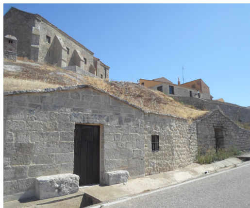
Figura 10. Barrio de bodegas. Tipologías de asentamiento en ladera con pendiente. (Fuente: F. Jové).
