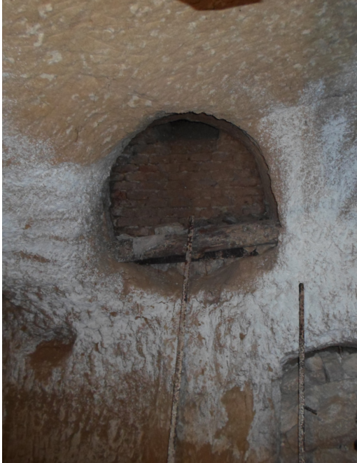
Figura 3. Bóveda de una bodega y nichos. Es posible observar las picotadas dadas en el terreno en el proceso constructivo de excavación de la bodega. (Fuente: F. Jové)
