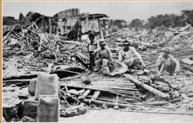
Fig. 2 Cúcuta destruida por el terremoto 1875 Fuente: Cúcuta a través de la fotografía
