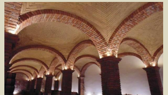
Fig. 4 Cubiertas en técnicas de adobitos recostados mexicanos Puebla, México (elaboración propia)
