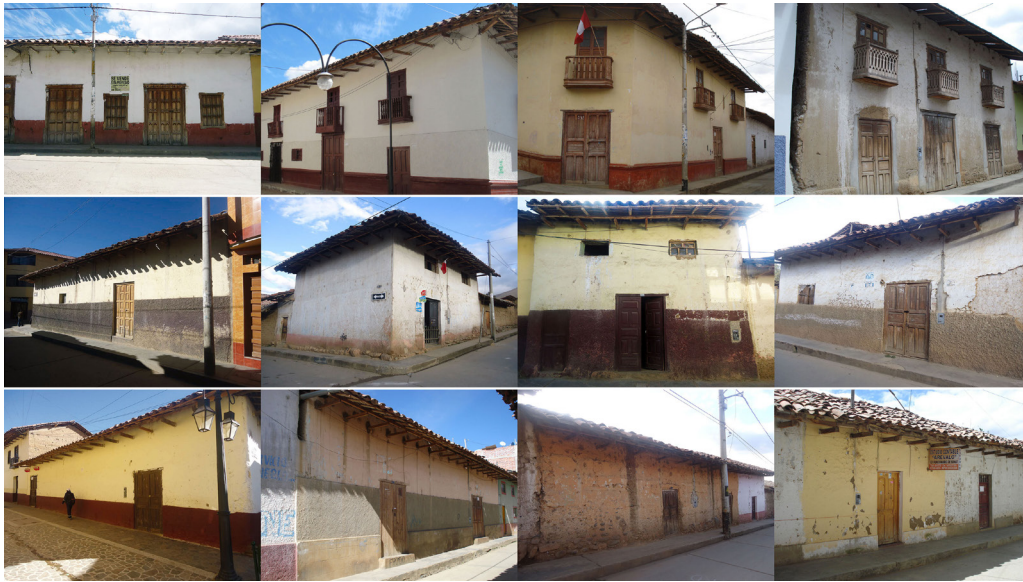
Figura 3. Vistas de fachadas típicas de edificios con vanos relativamente amplios y asociados a balcones en aquellos de dos niveles (fila superior, Escenario 1), fachadas típicas de edificios con vanos de dimensiones reducidas (fila central) y edificios con ausencia de vanos de ventana hacia la calle (fila inferior). Fuente: Martín Wieser.
