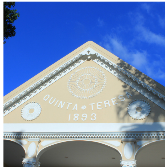
Figura 8. Detalles pórtico fachada principal en el año 2015. Fotografía: Camila Cárdenas Vela.
