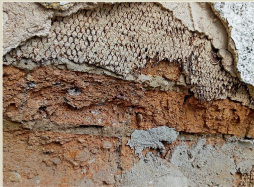
Fig. 4 Vivienda Av. primera con calle décima y once, Septiembre 2018 Fotografía: Elaboración propia
