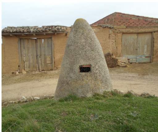
Figura 8. Chimenea de bodega de sección circular troncocónica. (Fuente: F. Jové).
