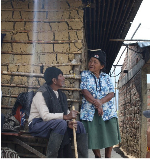
Figura 4: Detalle exterior casa Nasa en Jambalo (Cauca), uso de carrizo o caña para el bahareque de los muros y en el voladizo de la cubierta. Fuente: El autor.
