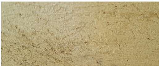
Ilustración 2 Acabado final de pañete muestra 1. Fuente: Elaboración propia. (López, 2017)
