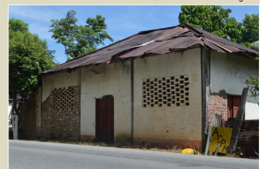
Fig. 8 Estación del ferrocarril Km 2 Puerto Santander 2018 Cortesía: Mayerly Rolón
