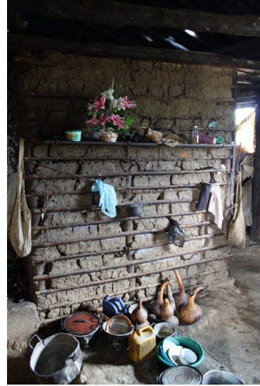
Figura 3: Detalle interior casa Nasa en Bahareque, postes y travesaños con madera rolliza, piso en tierra. Fuente: El autor.
