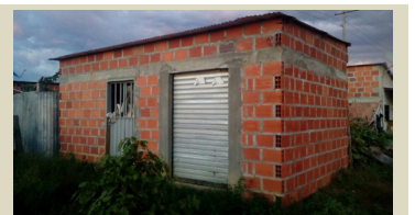
Fig. 2 Casa tradicional con cubierta de zinc y de poco aislamiento térmico ubicada en el barrio El Tucero – Pelaya Fuente: elaboración propia
