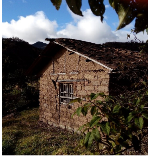
Figura 5: Casa Nasa, adobe de tierra en los muros y cubierta en teja de barro. Fuente: El autor.
