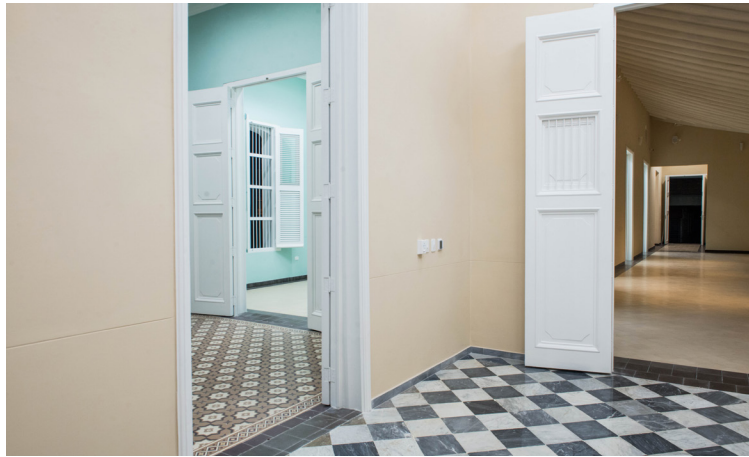
Figura 4. Vista interior de la Quinta Teresa de Cúcuta después de su restauración en el año 2014 Coordinación y recepción con piso en mármol, salones de administración en baldosa de cemento multicolor y monocolor. Fotografía: Diego Camacho Niño.
