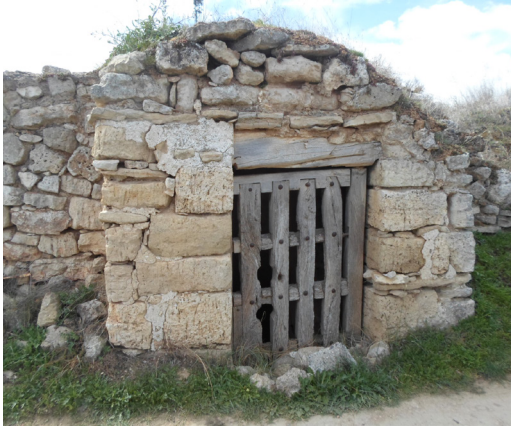
Figura 5. Puerta de acceso a bodega; tipo enrejado. (Fuente: F. Jové).
