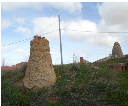
Figura 7. Chimenea de bodega de sección cuadrada. (Fuente: F. Jové).
