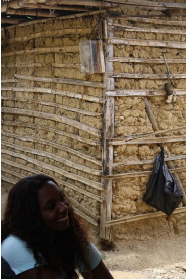
Figura 7: Detalle exterior casa afrodescendientes en Suárez (Cauca), construida en bahareque con lata de guadua y poste de madera rolliza. Fuente: El autor.
