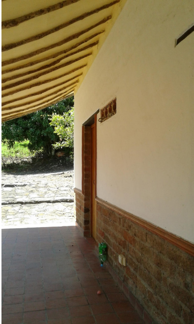
Figura 1. Fachada de una vivienda ubicada en la zona rural del municipio de Copacabana, Antioquia, en el cual se puede apreciar el recubrimiento exterior de la vivienda que se ha hecho con el material cagajón. Fuente: Propia
