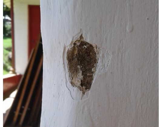
Figura 2. Patología encontrada en el revoque de la fachada que permite mostrar la materialidad del mismo. Copacabana, Antioquia. Fuente: Propia
