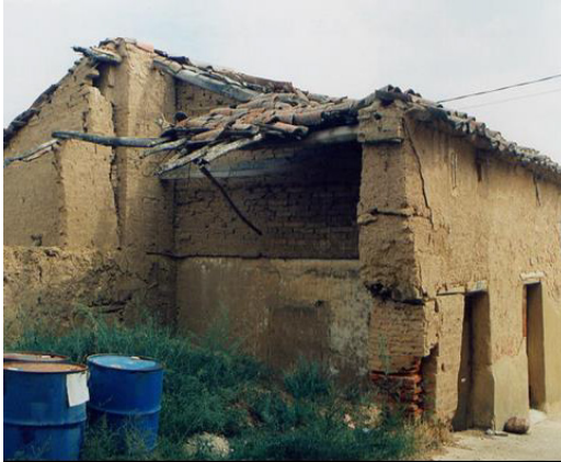
Fig. 2. Edificio residencial en ruinas en San Martín de Valderaduey, Zamora, donde se aprecia el espesor de los muros de tierra y la formación de la cubierta. Fuente: José Luis Sainz Guerra.
